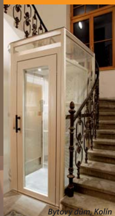
Bytový dům, Kolín
